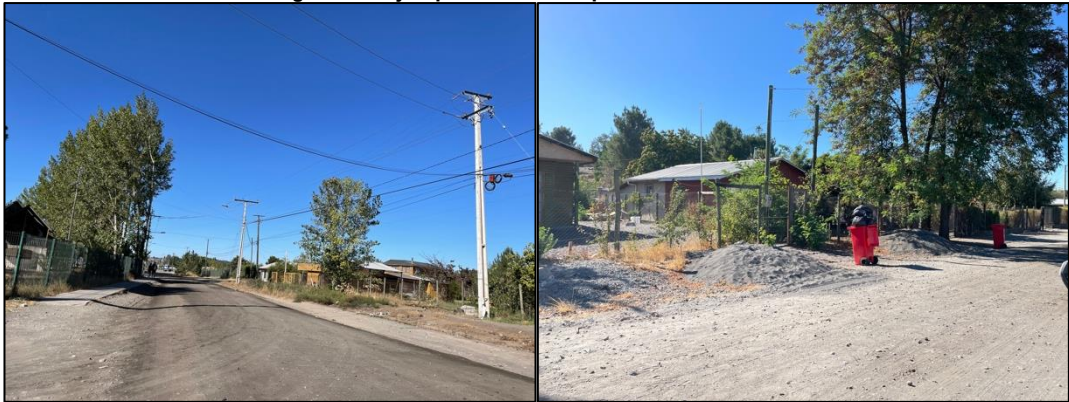
Figura 23: Ejemplo de vías sin pavimentos
